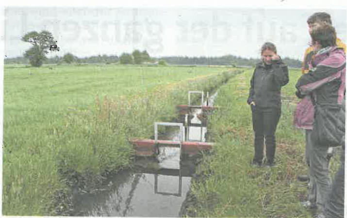
Die Stauwehre regulieren und messen den Zu- und Abfluss des Grabenwassers bei der Unterflurbewässerung.
